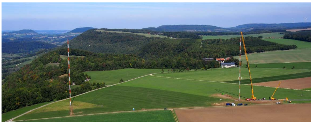
Abbildung 4: Luftbild der temporär genehmigten Windmessmasten WMM-NW (links) und WMM-NO (rechts). Der geplante Anlagenstandort der nördlichen FWEA liegt exakt zwischen beiden Messmasten. Links im Bildrand befindet sich die nach Westen ausgerichtete Geländesteilstufe. [Foto: WindForS].
