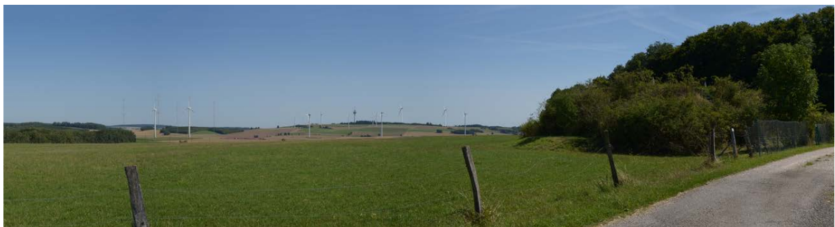
Abbildung 20: Visualisierung mit Testfeld und den zwei geplanten WEA im GP-10 „Stöttener Berg (Zoom) [Quelle: TUM-LAREG].
