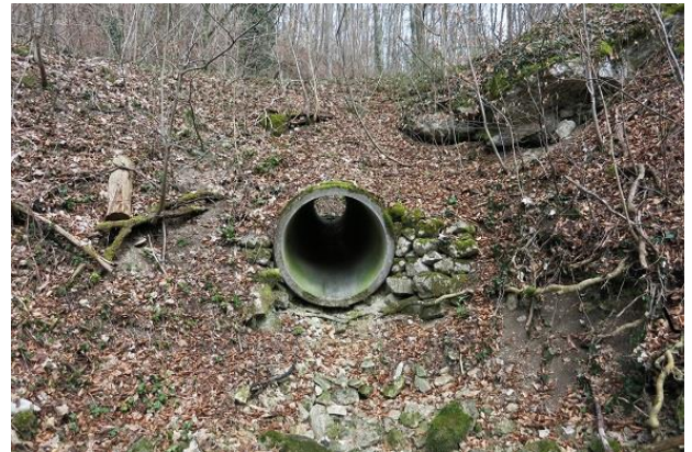
Abbildung 187: Rohrdurchlass im Bereich der Waldwegekreuzung (Blick gegen Fließrichtung)
