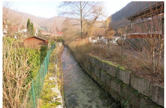
Abbildung 74: Massive Uferbefestigung zwischen Hausgärten und Gewerbe (Blick gegen Fließrichtung)
