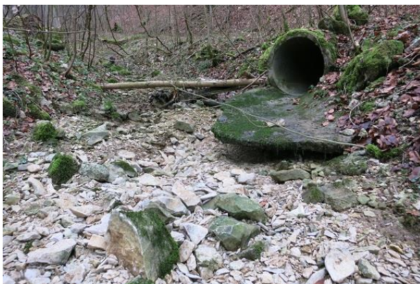
Abbildung 161: Seitlicher Zulauf über ein Rohr (Blick gegen Fließrichtung)
