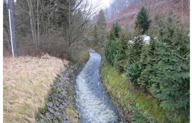
Abbildung 76: Massive Uferbefestigung zwischen Hausgärten und Gewerbe (Blick gegen Fließrichtung)
