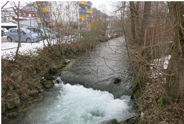
Abbildung 117: Mündung in die Eyb (im Bild links oberhalb Absturz, Blick gegen Fließrichtung)
