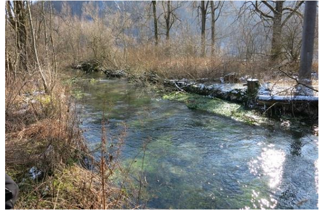
Abbildung 104: Steinschüttungen als Uferbefestigung (Blick gegen Fließrichtung)
