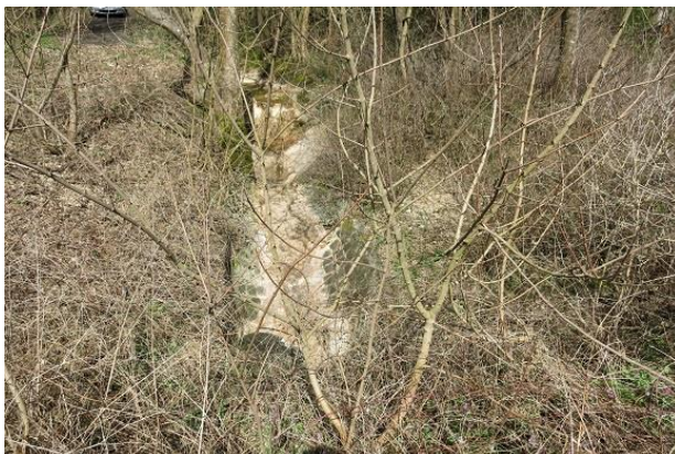
Abbildung 184: Massiv verbaute Ufer oberhalb der L1221 (Blick gegen Fließrichtung)
