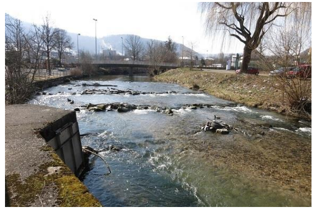
Abbildung 18: Durchgängige Sohlstufen auf Höhe des Biergartens (Blick gegen Fließrichtung)
