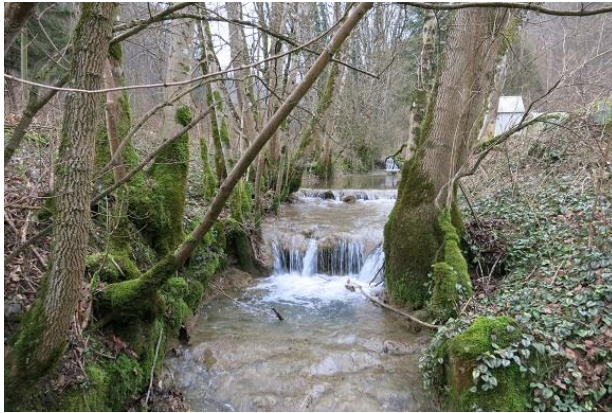
Abbildung 153: Versinterte Sohlstufen im Gewässer (Blick gegen Fließrichtung)
