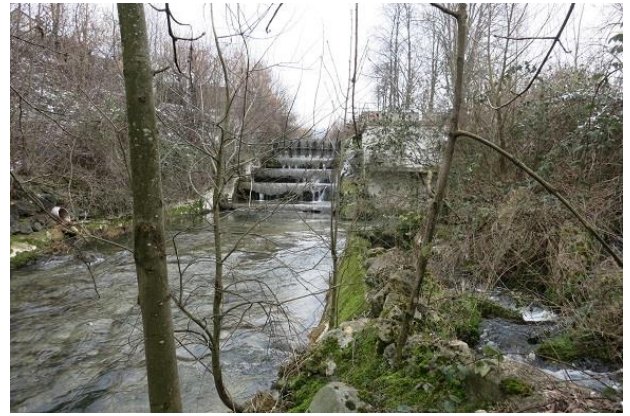
Abbildung 54: Wehr mit Fischpass auf Höhe des 5-Täler-Bads (Blick gegen Fließrichtung)
