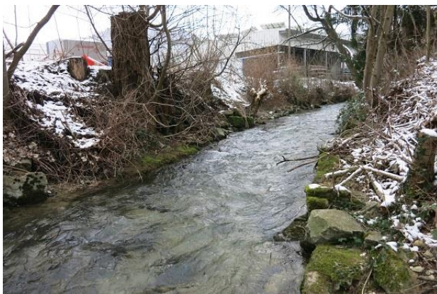
Abbildung 55: Grobe Steinschüttung als Ufersicherung (Blick gegen Fließrichtung)
