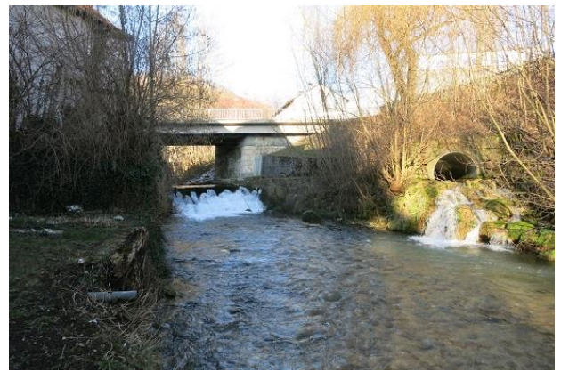
Abbildung 58: Wehrrest und Mündung des Siebenquellenbachs (Blick gegen Fließrichtung)
