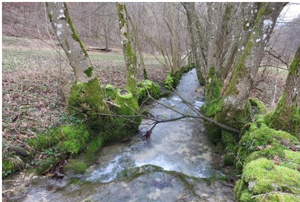
Abbildung 155: Mit Moos bewachsene Steinsicherungen (Blick in Fließrichtung)
