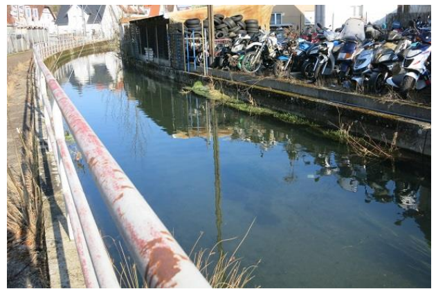
Abbildung 98: Dicht angrenzende Nutzung an der verbauten Rohrach (Blick in Fließrichtung)
