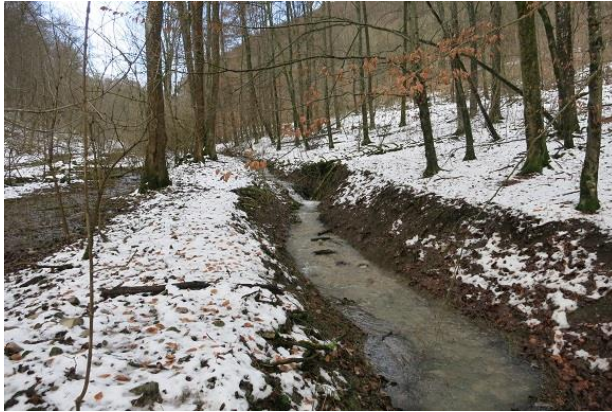
Abbildung 135: Verweigter Verlauf des Talgrabenbachs (Blick gegen Fließrichtung)
