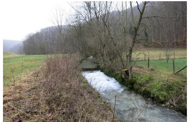
Abbildung 84: Wehr an der Ausleitungsstelle für die Fischteichanlage (Blick gegen Fließrichtung)
