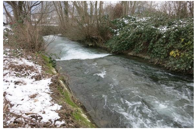
Abbildung 46: Sohlabsturz mit Uferbefestigung (Blick in Fließrichtung)
