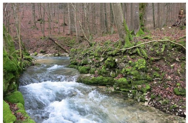
Abbildung 80: Sohlschwelle aus anstehendem Gestein (Blick gegen Fließrichtung)
