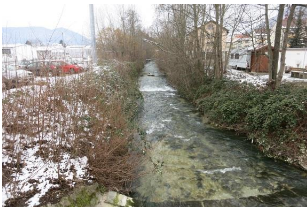
Abbildung 49: Geradliniger Verlauf der Eyb mit Sohlabstürzen (Blick in Fließrichtung)
