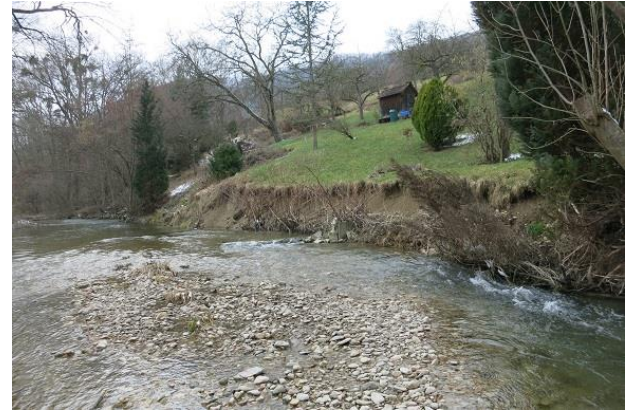
Abbildung 34: Japanknöterich am Erosionshang (Blick gegen Fließrichtung)
