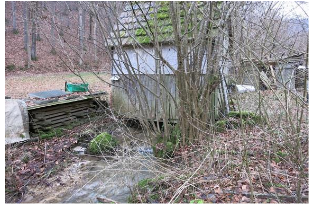
Abbildung 154: Lagerflächen und Holzhütten als anthropogene Beeinträchtigung (Blick gegen Fließrichtung)
