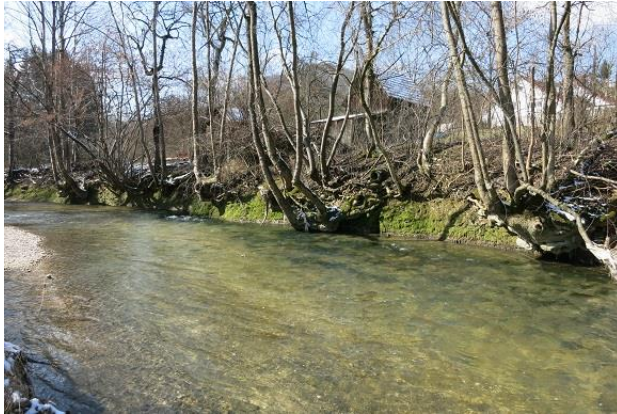
Abbildung 21: Natürliche Ufersicherung aus Gehölzen und anstehendem Fels (Blick gegen Fließrichtung)
