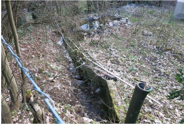
Abbildung 113: Wilder Uferverbau und Teich im Bereich des Nutzgartens (Blick in Fließrichtung)
