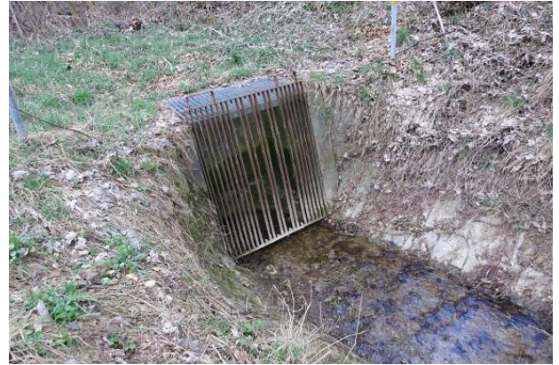
Abbildung 175: Einlauf in die Verdolung oberhalb der L1221
