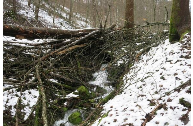
Abbildung 136: Verklausung und Totholz am Ende der Verdolungsstrecke (Blick gegen Fließrichtung)
