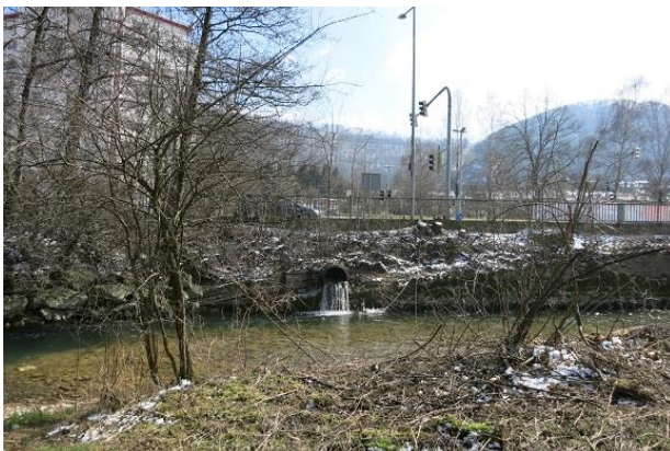
Abbildung 37: Mündung in die Fils (Blick gegen Fließrichtung)
