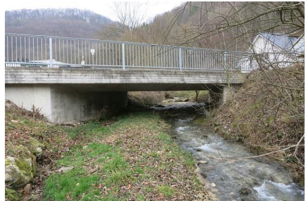
Abbildung 152: Brücke im Bereich der Straße Langwiesen (Blick gegen Fließrichtung)
