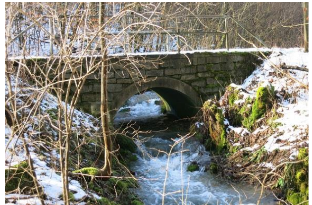
Abbildung 132: Durchlass im Bereich einer Wegekreuzung (Blick gegen Fließrichtung)
