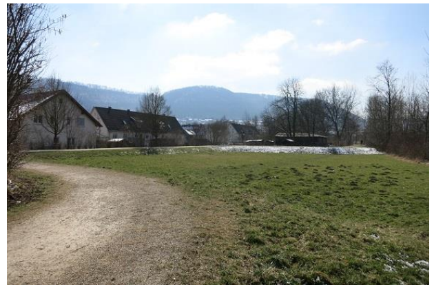
Abbildung 24: Damm mit Fuß- und Radweg als Hochwasserschutzanlage (Blick talaufwärts)
