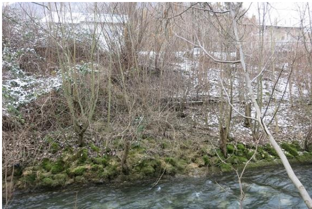
Abbildung 51: Massive Uferbefestigung entlang der Eyb
