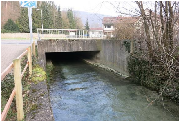
Abbildung 71: Verdolung im Bereich der von-Degenfled-Straße (Blick gegen Fließrichtung)
