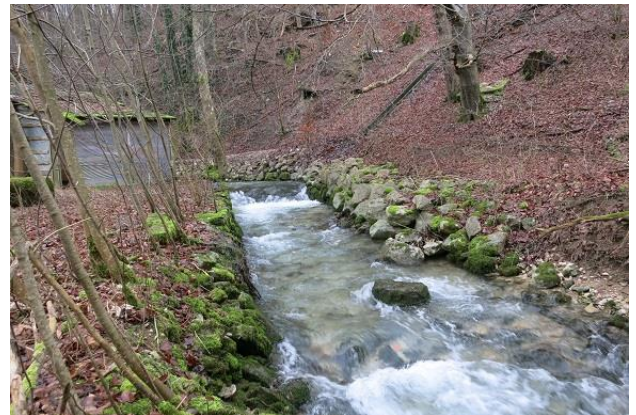
Abbildung 78: Steinsatz als Ufersicherung (Blick gegen Fließrichtung)
