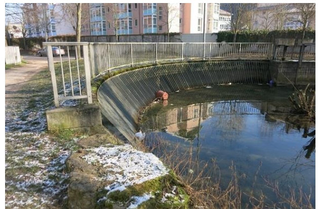
Abbildung 96: Einlaufbauwerk mit Abzweig des Flößgrabens (Blick in Fließrichtung)
