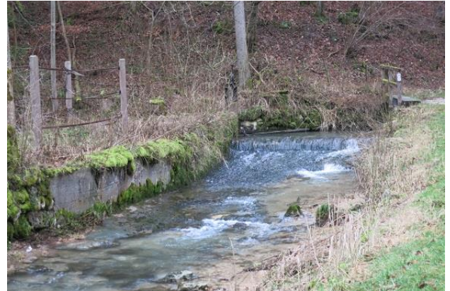
Abbildung 88: Wehranlage der Unteren Roggenmühle (Blick gegen Fließrichtung)
