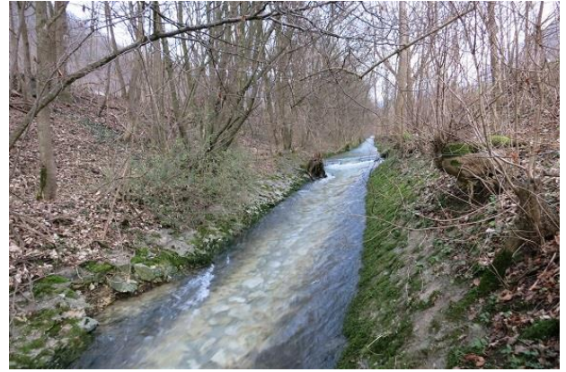
Abbildung 64: Geradliniger Verlauf mit Sohlstufen in der Eyb (Blick gegen Fließrichtung)
