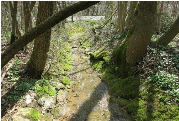
Abbildung 182: Massiv verbaute Ufer oberhalb der L1221 (Blick in Fließrichtung)
