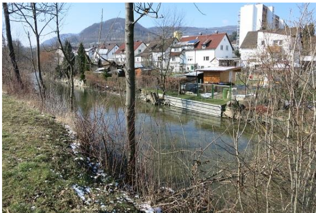
Abbildung 19: Wilder Uferverbau im Bereich der Hausgärten (Blick gegen Fließrichtung)
