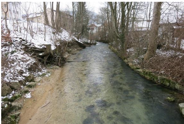
Abbildung 57: Uferabbrüche (links) im eingetieften Gewässerprofil (Blick in Fließrichtung)
