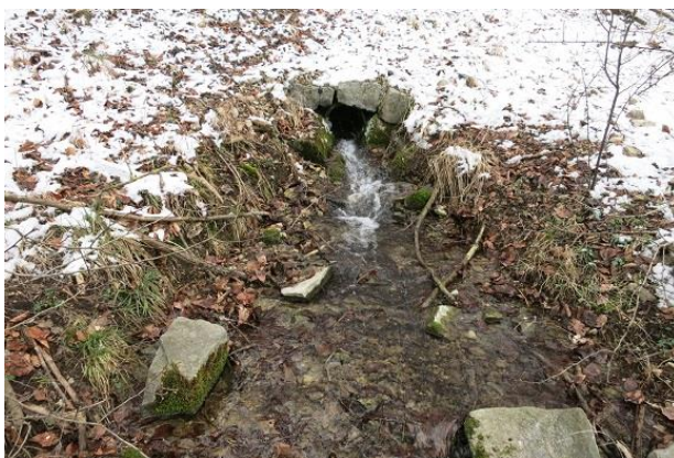
Abbildung 43: Auslauf aus der Verdolung (Blick gegen Fließrichtung)
