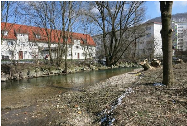
Abbildung 27: Grobe Steinschüttung als Ufersicherung (Blick gegen Fließrichtung)
