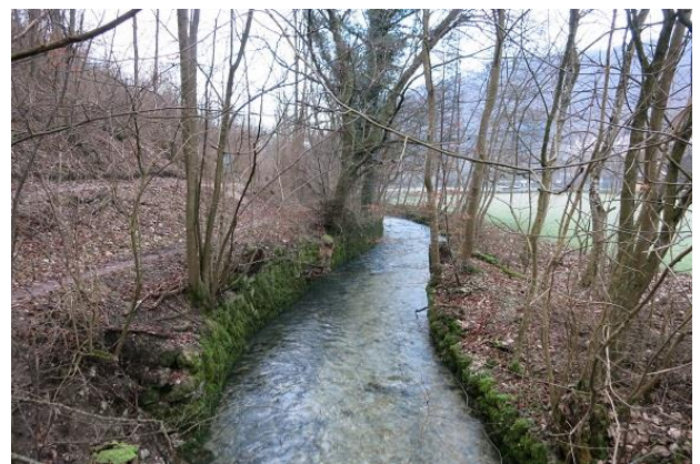
Abbildung 66: Steinsatz als Ufersicherung an der Eyb (Blick in Fließrichtung)
