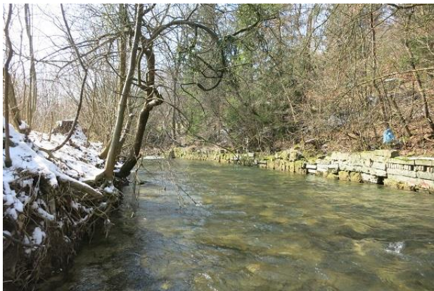
Abbildung 23: Ufersicherungen aus Steinen entlang von Obstwiesen (Blick gegen Fließrichtung)
