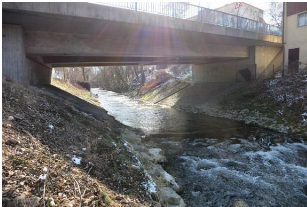
Abbildung 15: Brücke mit Pegel der HVZ (Blick gegen Fließrichtung)
