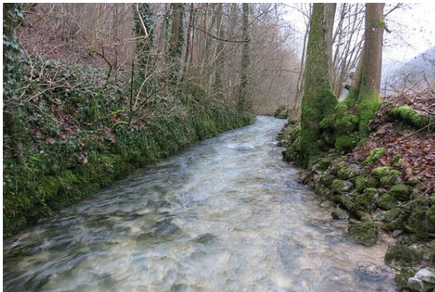
Abbildung 85: Mit Moos überwachsene Ufersicherung aus Steinen (Blick in Fließrichtung)
