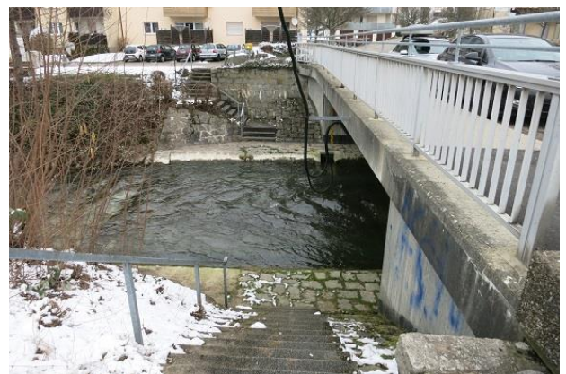
Abbildung 50: Pegelanlage im Bereich der Gutenbergstraße
