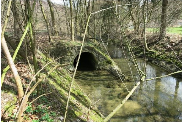
Abbildung 174: Mündung in die Eyb (Blick gegen Fließrichtung)
