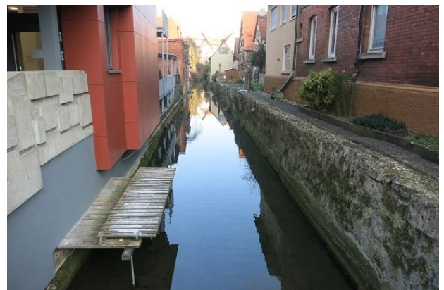
Abbildung 92: Begradigter Verlauf zwischen angrenzenden Gebäuden (Blick in Fließrichtung)
