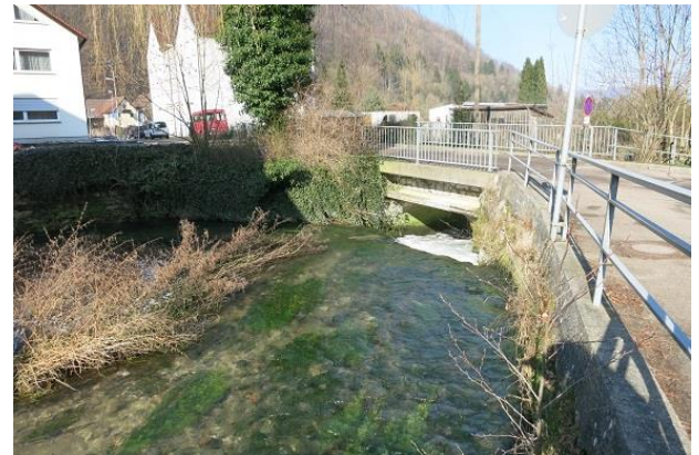
Abbildung 100: Kreuzungsbauwerk im Bereich „Rorgensteig“ (Blick in Fließrichtung)
