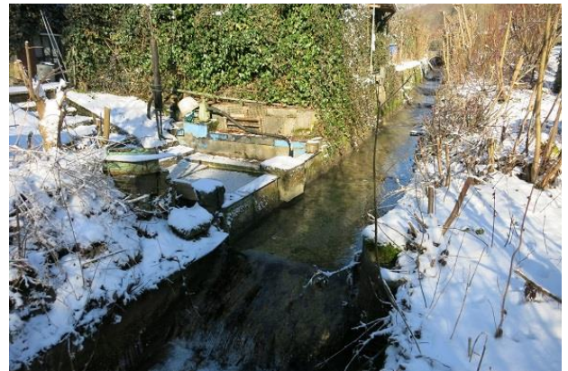
Abbildung 128: Dicht angrenzende Kleingartennutzung (Blick gegen Fließrichtung)
