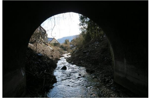
Abbildung 120: Tunnel im Bereich der Bahnstrecke (Blick in Fließrichtung)
