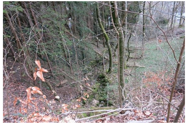
Abbildung 183: Steinbefestigung als Ufersicherung im steilen Gelände (Blick talabwärts)
