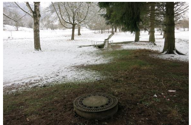
Abbildung 38: Verdolungsstrecke und ausgebauter Bach (Blick gegen Fließrichtung)
