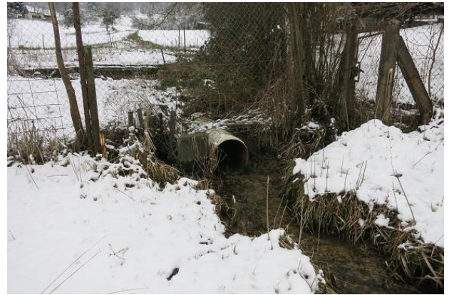
Abbildung 40: Rohrdurchlass unterhalb der Fischteichanlage (Blick gegen Fließrichtung)
