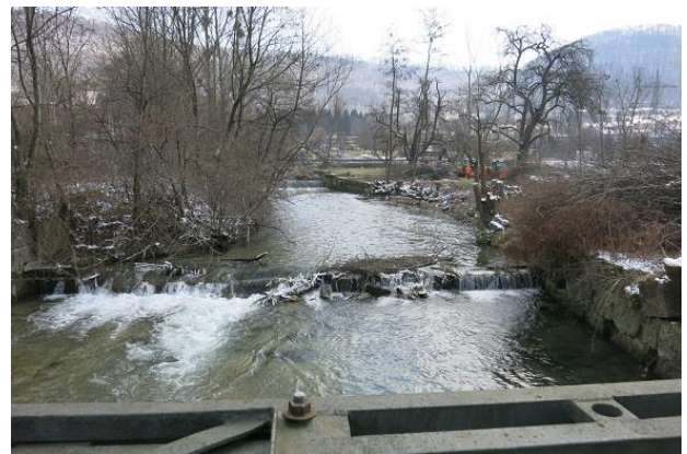
Abbildung 26: Steinwurf und Gabionen als Uferbefestigung (Blick gegen Fließrichtung)
