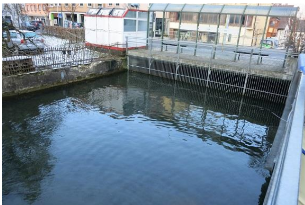
Abbildung 91: Einlauf in die Verdolung (Blick in Fließrichtung)
