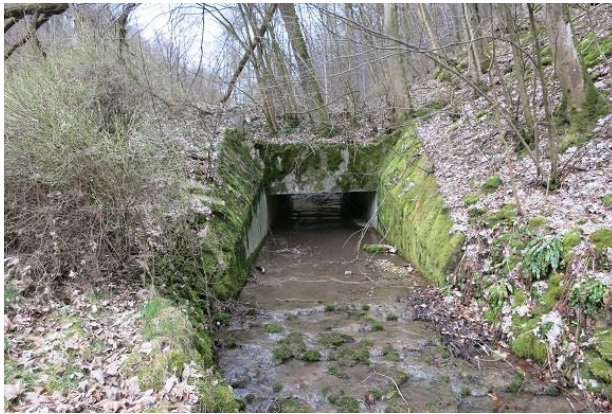
Abbildung 111: Durchlass mit befestigten Ufern und Sohle (Blick gegen Fließrichtung)
