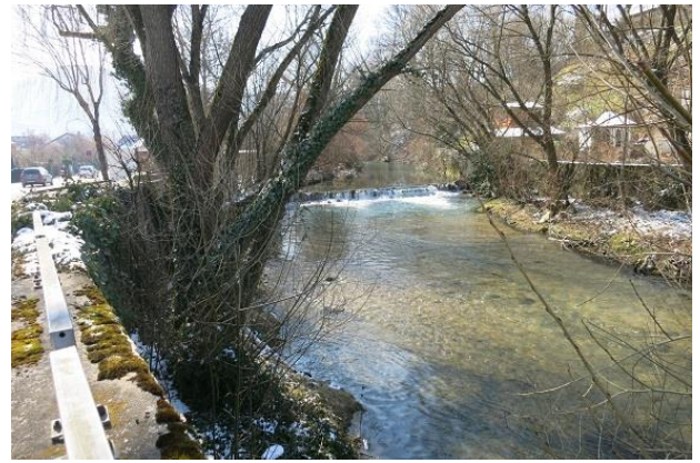
Abbildung 16: Sohlabsturz in der Fils (Blick gegen Fließrichtung)
