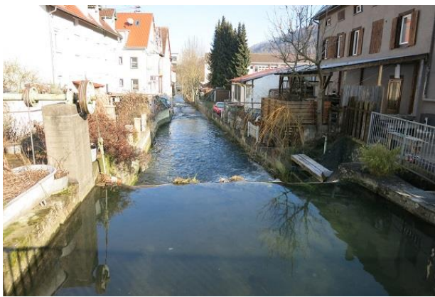
Abbildung 97: Wehranlage unterhalb der Seestraße (Blick in Fließrichtung)
