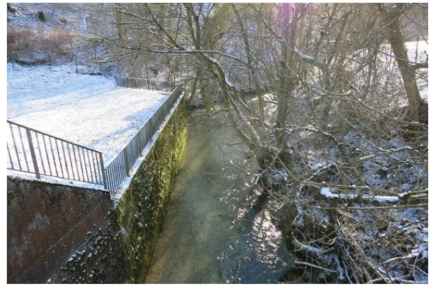
Abbildung 60: Uferbefestigungen im Bereich des Wasserwerks (Blick in Fließrichtung)
