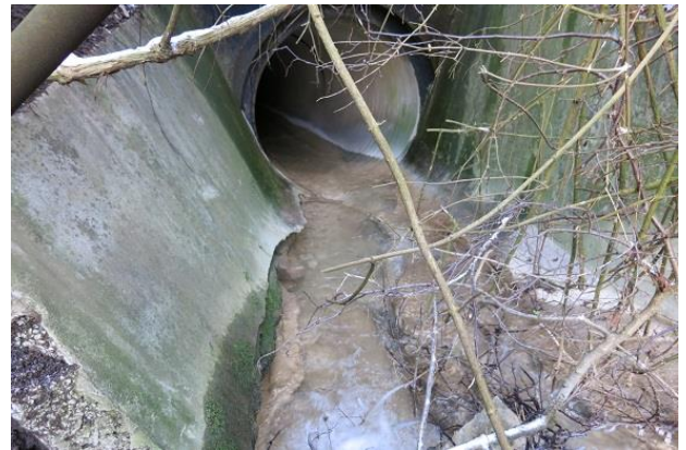
Abbildung 118: Einlauf in die Verdolung oberhalb der Längentalstraße (Blick in Fließrichtung)
