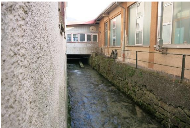
Abbildung 73: Verdolung und angrenzende Bebauung oberhalb der Roggentalstraße (Blick gegen Fließrichtung)
