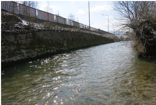
Abbildung 29: Ufermauer entlang der Überkinger Straße (Blick gegen Fließrichtung)
