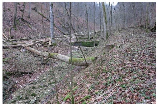
Abbildung 162: Südliche Arm mit Auslaufbauwerk (Blick talaufwärts)
