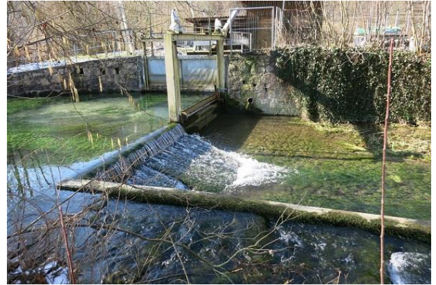
Abbildung 102: Wehr mit Ableitung zur Fischzuchtanlage
