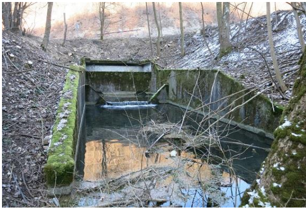
Abbildung 107: Auslauf der Verdolung mit Absturz und befestigten Ufern (Blick gegen Fließrichtung)
