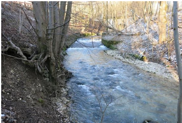
Abbildung 59: Absturz mit glatter Rampe unterhalb der Bahnlinie (Blick gegen Fließrichtung)
