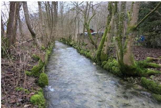
Abbildung 81: Mit Moos überwachsene Ufersicherung aus Steinen (Blick gegen Fließrichtung)
