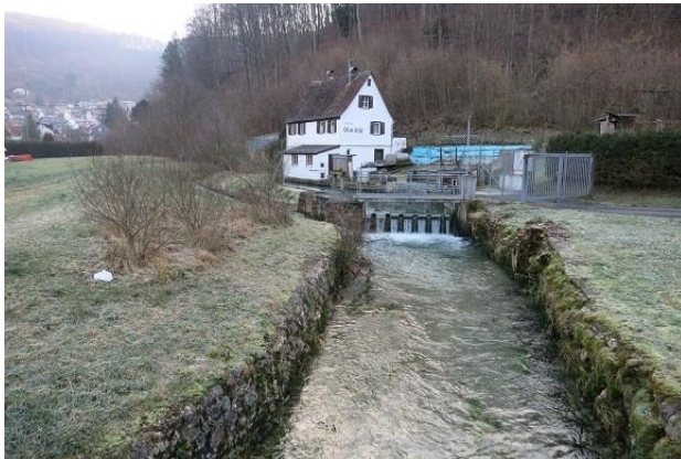
Abbildung 69: Ölmühle mit Wehr und Umgehungsgerinne (Blick gegen Fließrichtung)
