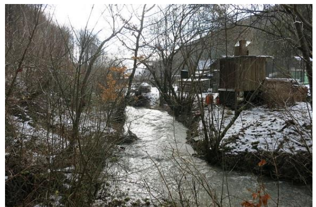
Abbildung 130: Hütten im Gewässerrandstreifen (Blick in Fließrichtung)
