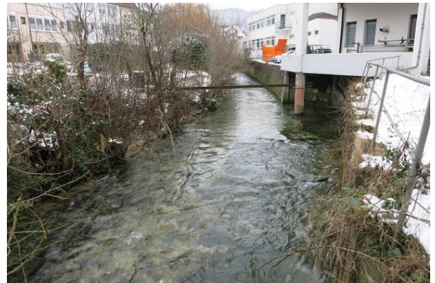
Abbildung 52: Wilder Verbau und Gebäudemauern als Ufersicherung (Blick gegen Fließrichtung)
