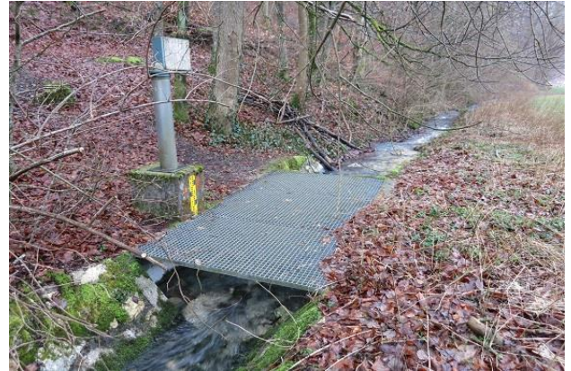
Abbildung 169: Messstation (Blick in Fließrichtung)
