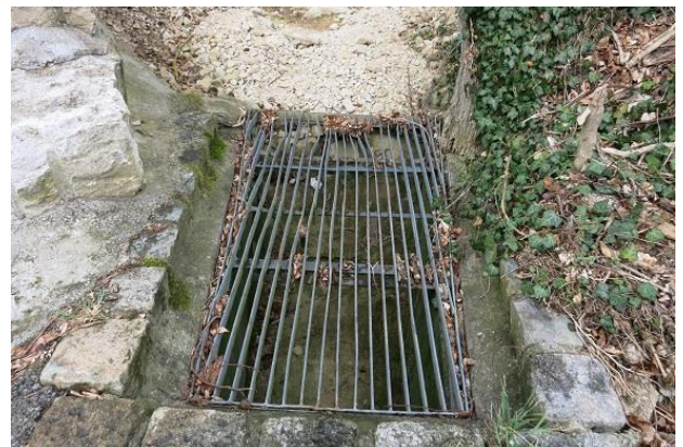
Abbildung 185: Einlauf mit Gitter oberhalb der Straße Oßmannsweiler
