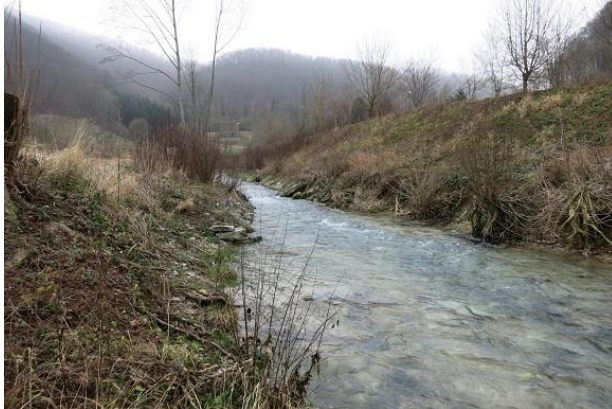
Abbildung 75: Verdolung und angrenzende Bebauung oberhalb der Roggentalstraße (Blick gegen Fließrichtung)
