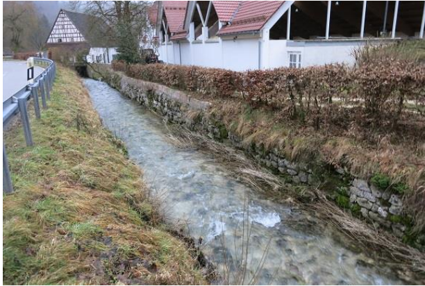
Abbildung 87: Eyb zwischen Straße und Roggenmühle (Blick in Fließrichtung)
