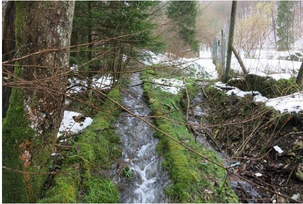
Abbildung 141: Ufer- und Sohlbefestigung am Gewässer (Blick gegen Fließrichtung)
