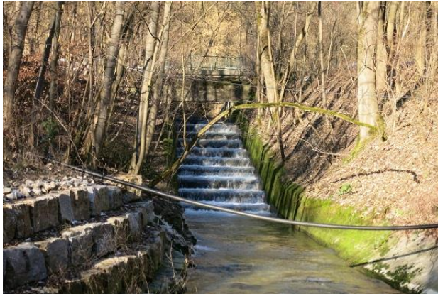
Abbildung 63: Kaskadenartige Abstürze unterhalb der Sportanlagen (Blick gegen Fließrichtung)
