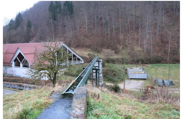
Abbildung 167: Aquädukt über die Straße K1449 in Richtung Mühlkanal (Blick in Fließrichtung)
