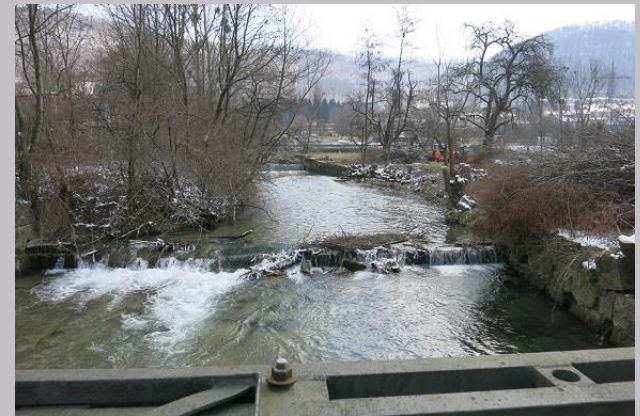
Steinwurf und Gabionen als Uferbefestigung (Blick gegen Fließrichtung)
