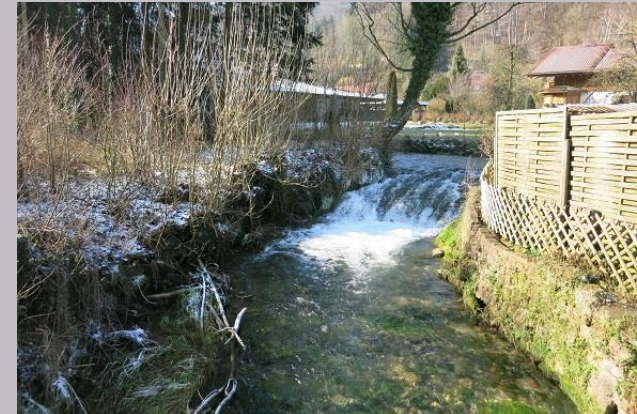
Wehr einer ehemal. Wasserkraftanlage (Blick gegen Fließrichtung)
