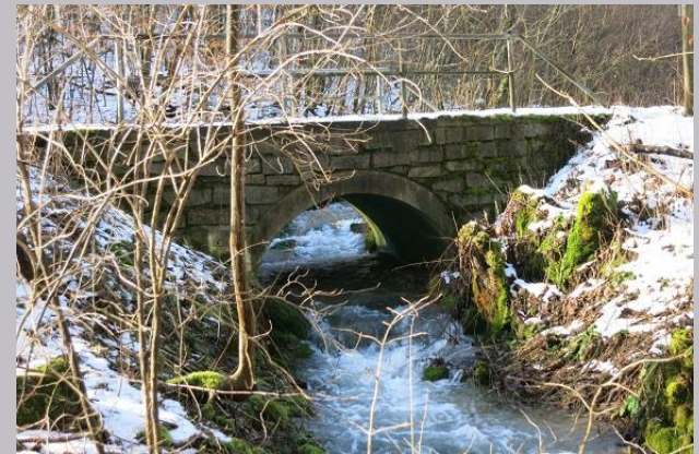
Durchlass im Bereich einer Wegekreuzung (Blick gegen Fließrichtung)
