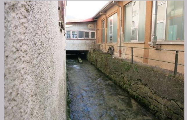
Verdichtung und angrenzende Bebauung oberhalb der Roggentalstraße
