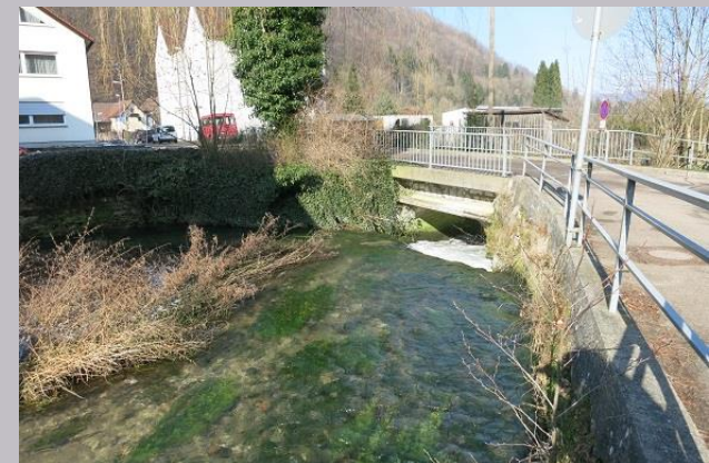
Kreuzungsbauwerk im Bereich „Rorgensteig“ (Blick in Fließrichtung)
