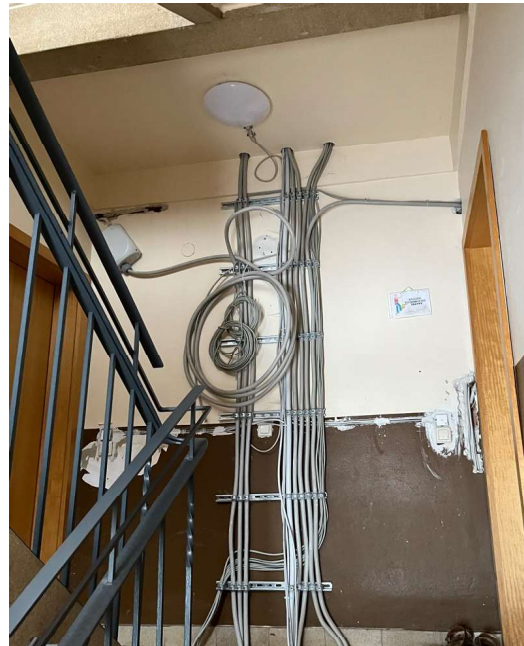
Bild: Rheinlandstr. 2-4 Neuinstallation Elektrik
