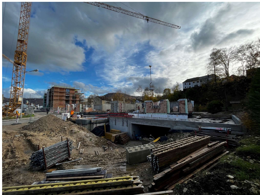
Bild: Bruckwiesen Tiefgarage Haus C
