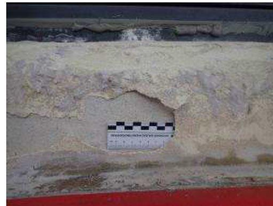
Bilder 15,16: Zustand Verbundabdichtung und Untergrund am Beckenkopf, Innenseite
