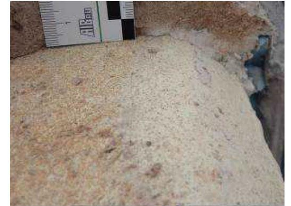
Bilder 25,26: links Fehlstellen der Besandung, rechts ungleichmäßige Quarzsandabstreifung
