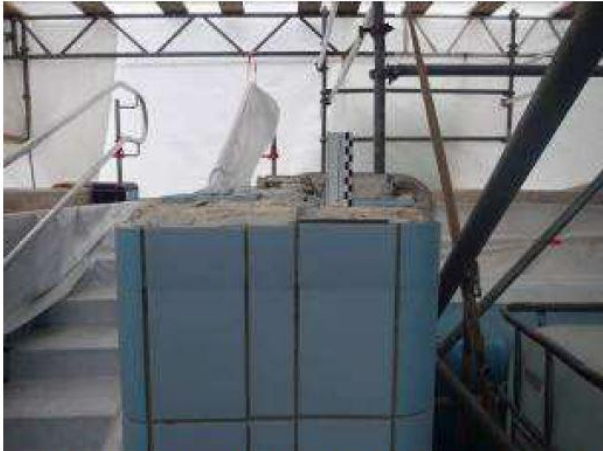
Bilder 3,4: Zustand Beckenkopf / Schichtenaufbau
