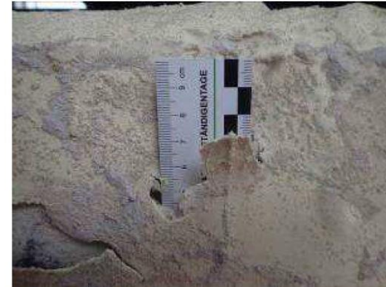
Bilder 25,26: links Fehlstellen der Besandung, rechts ungleichmäßige Quarzsandabstreifung
