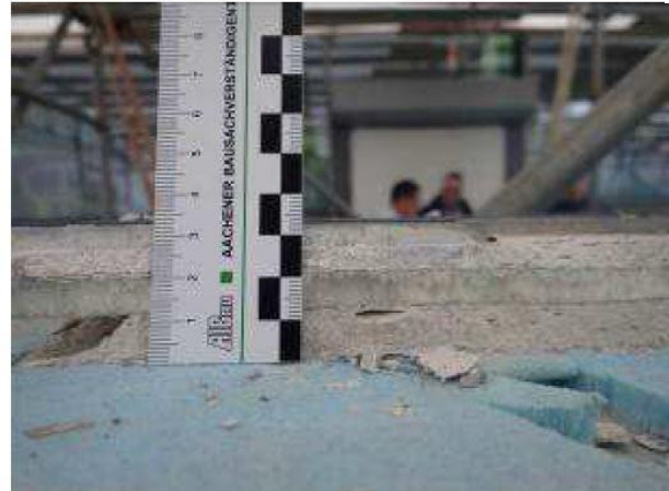
Bilder 15,16: Zustand Verbundabdichtung und Untergrund am Beckenkopf, Innenseite
