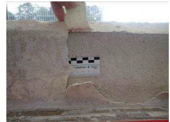
Bilder 15,16: Zustand Verbundabdichtung und Untergrund am Beckenkopf, Innenseite
