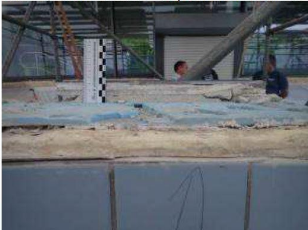
Bilder 5,6: Zustand Beckenkopf / Schichtenaufbau
