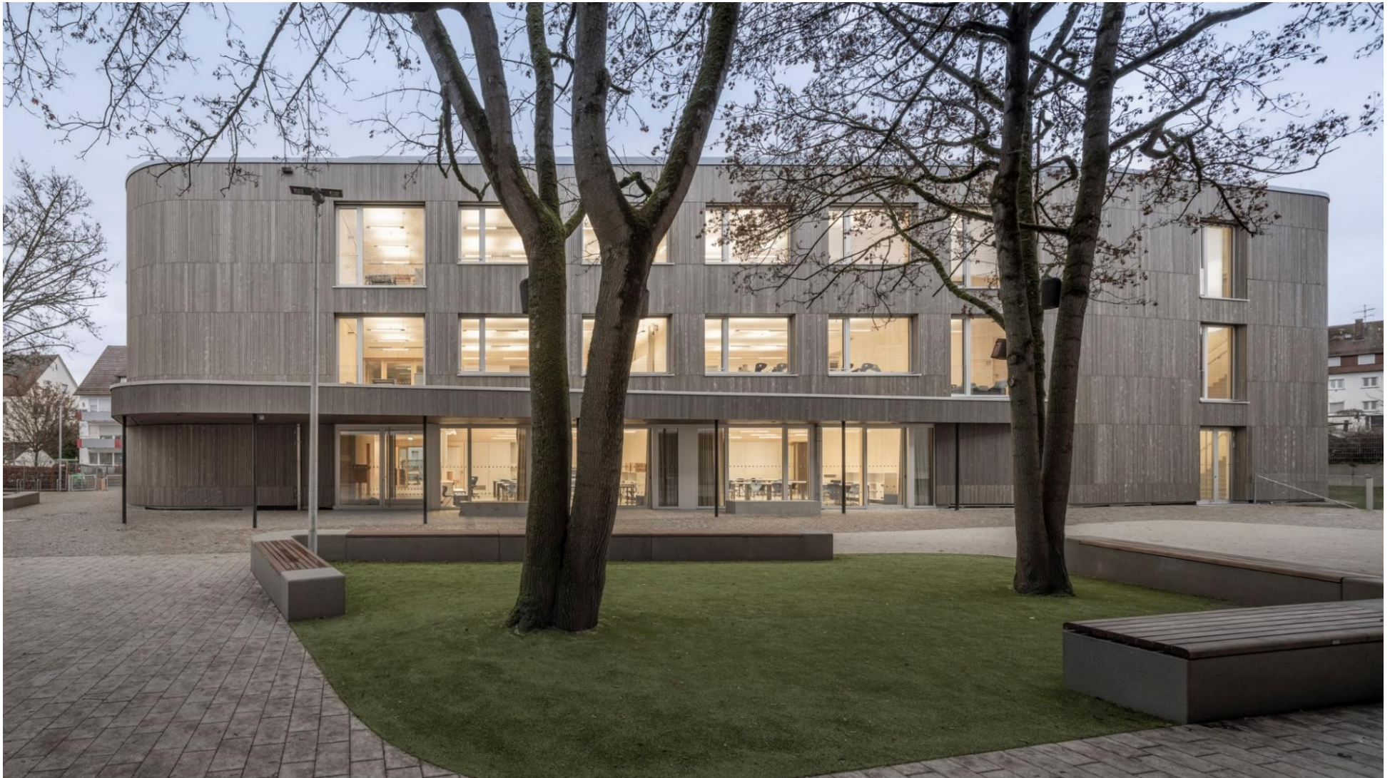
V1 Holzfassade, Grundschule, Stuttgart Stammheim, grau vorgestrichen
