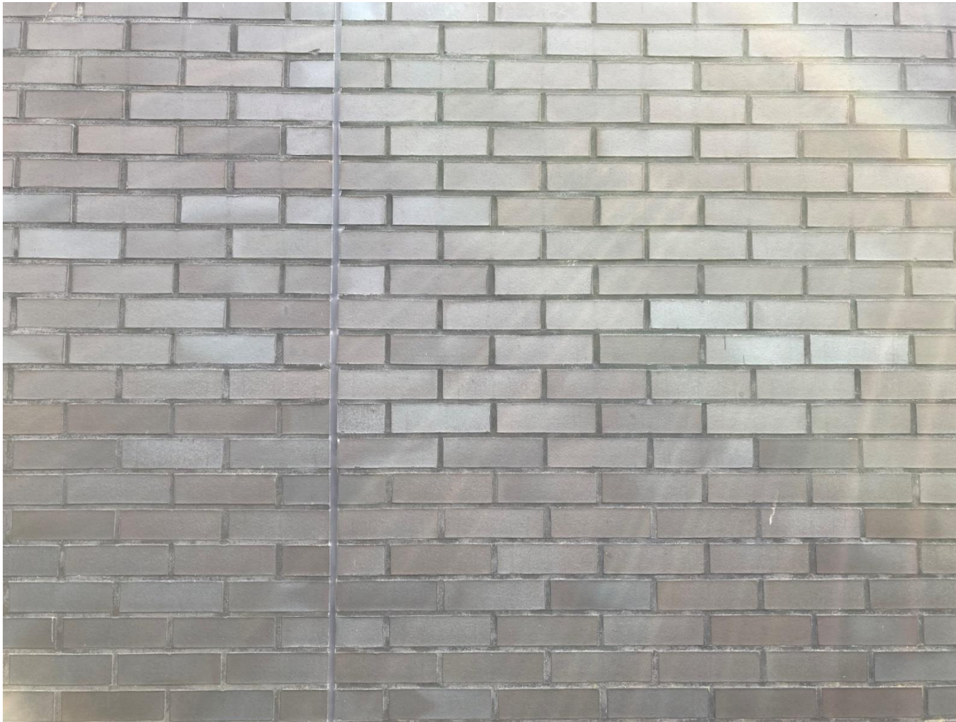
Ziegelfassade Südliches Nachbargebäude (Hochhaus) Helfenstein Gymnasium
