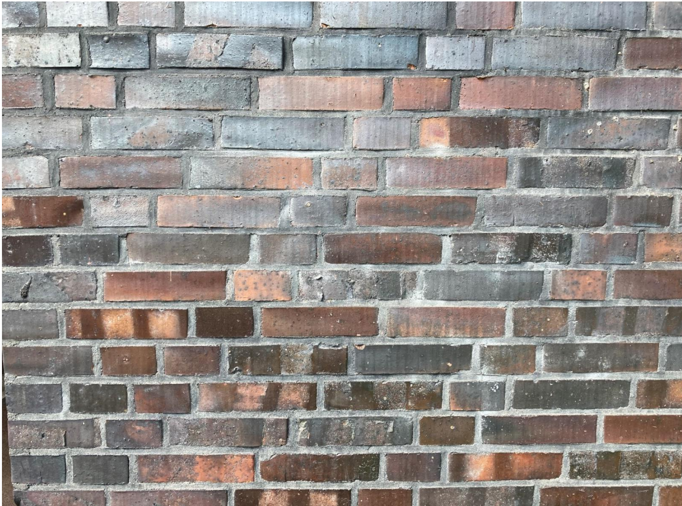
Ziegelfassade Bestand Helfenstein Gymnasium Sockelbereich
