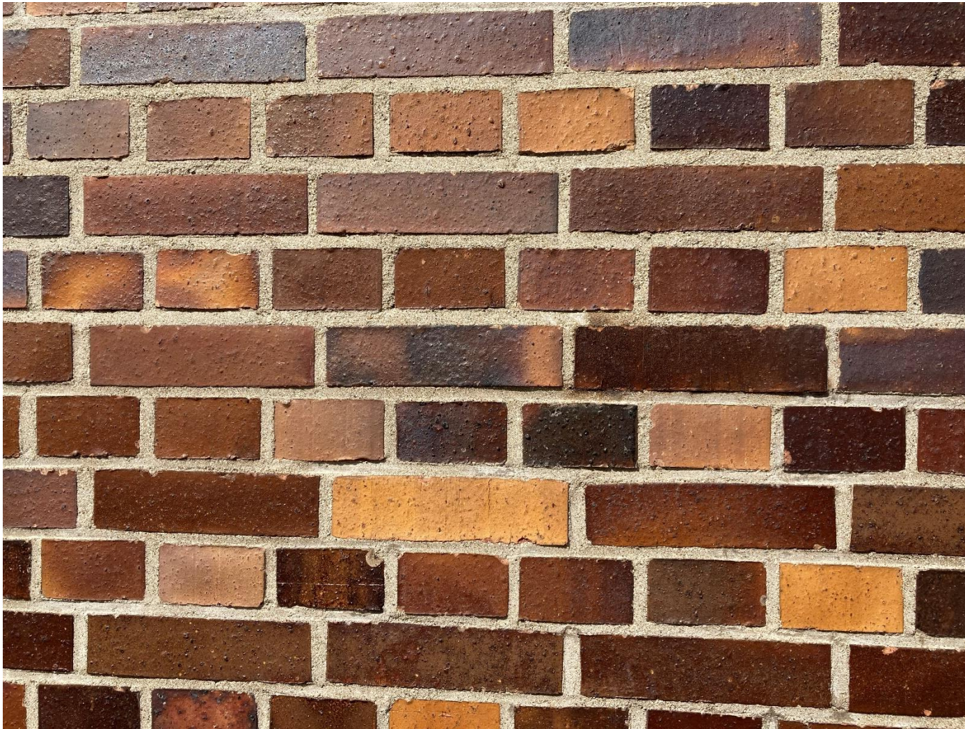
Ziegelfassade benachbarte nördliche Trafostation
