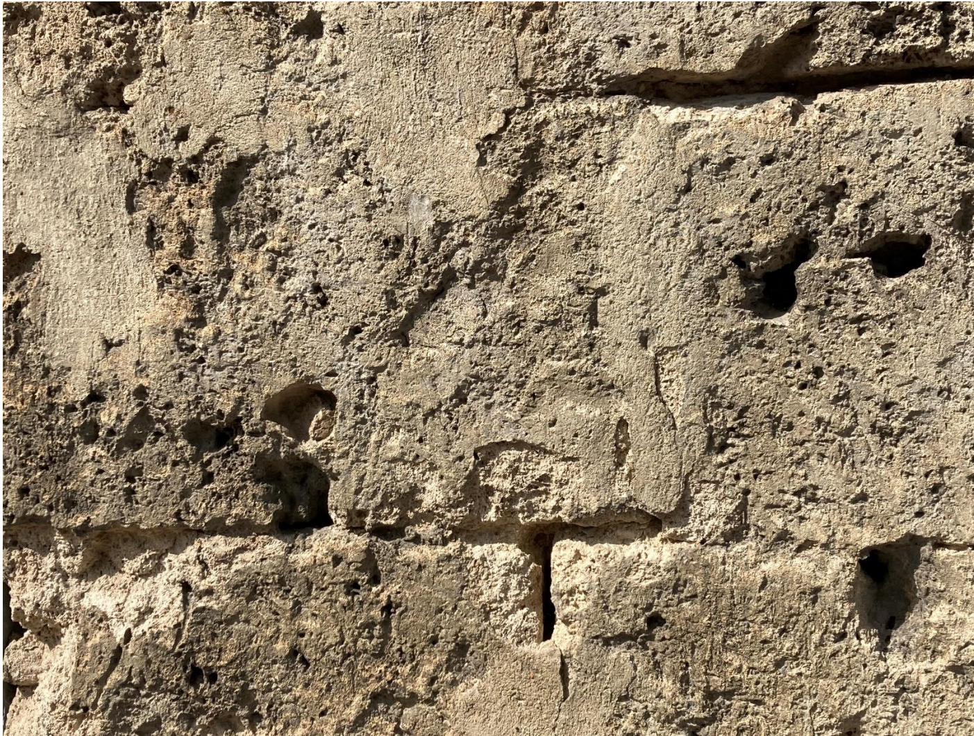
Tuffsteinfassade nördliche benachbarte Wohngebäude Kaiser Wilhelm Straße, Sockelbereich
