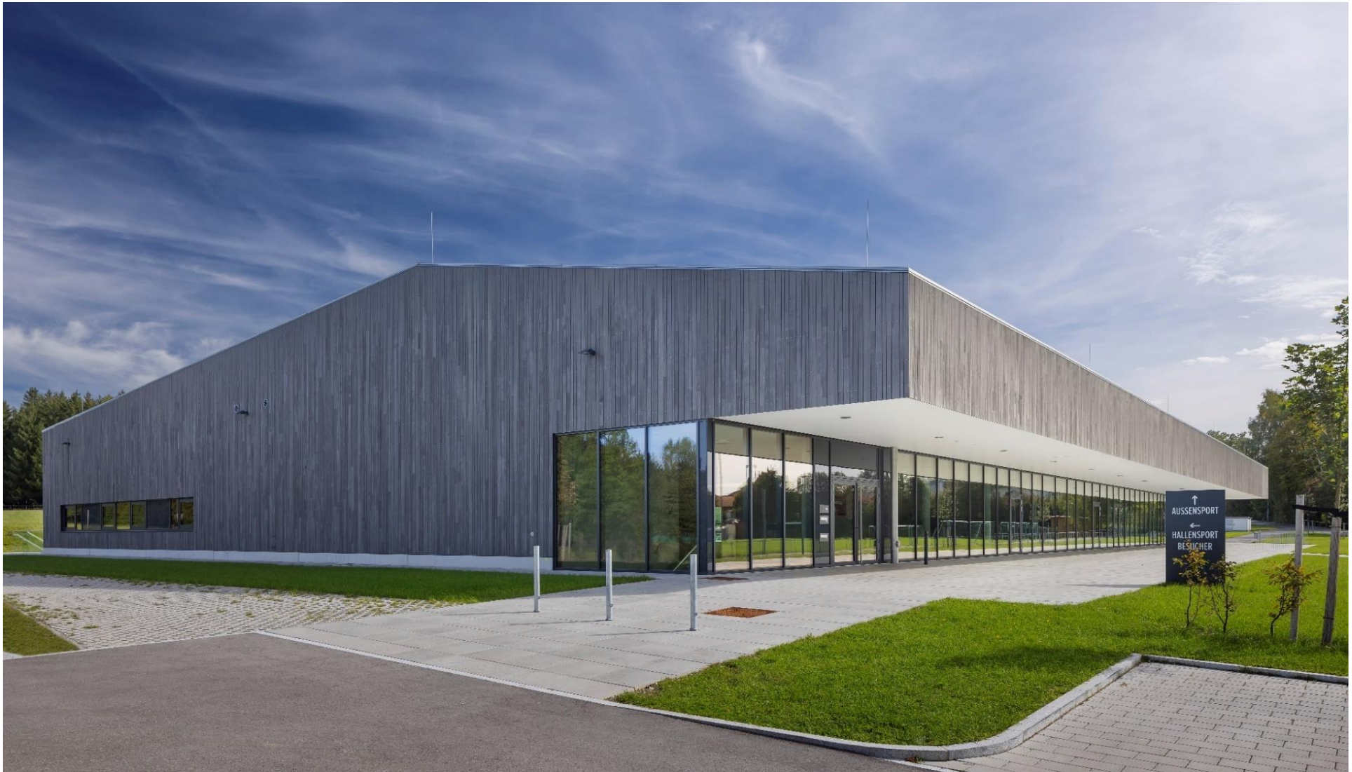
V1 Holzfassade, Sporthalle Mauerstetten, grau vorgestrichen
