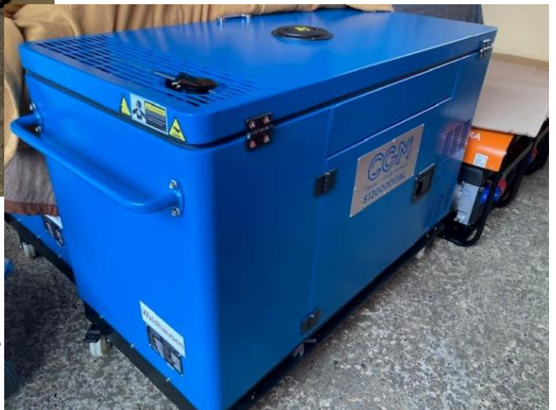
Drei Notstromaggregate (12 KVA) für die FW-Häuser Eybach, Waldhausen und Aufhausen.
