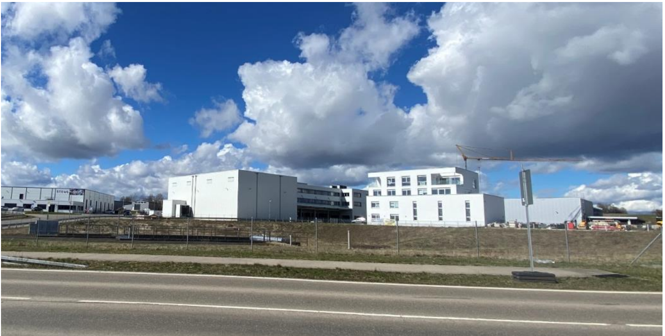
Neubau Trockenlager und Kühlhallen mit Büromezzaninen, Werkstattgebäude, Parkhaus und LKW-Unterstand (BÄKO)
