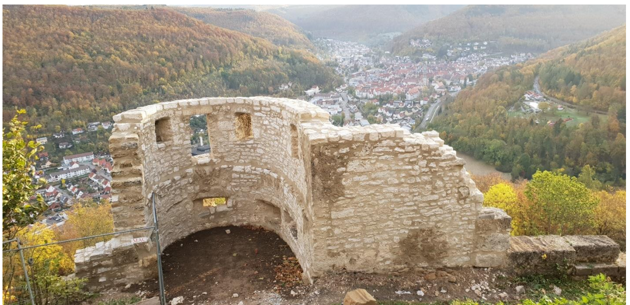
Fertiggestellte Verfugung im Trockenspritzverfahren (Beispielbild)
