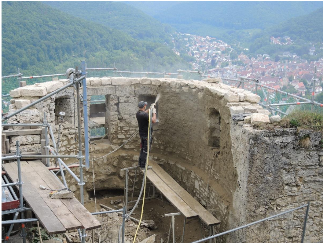
Verfugung im Trockenspritzverfahren während der Ausführung (Beispielbild)
