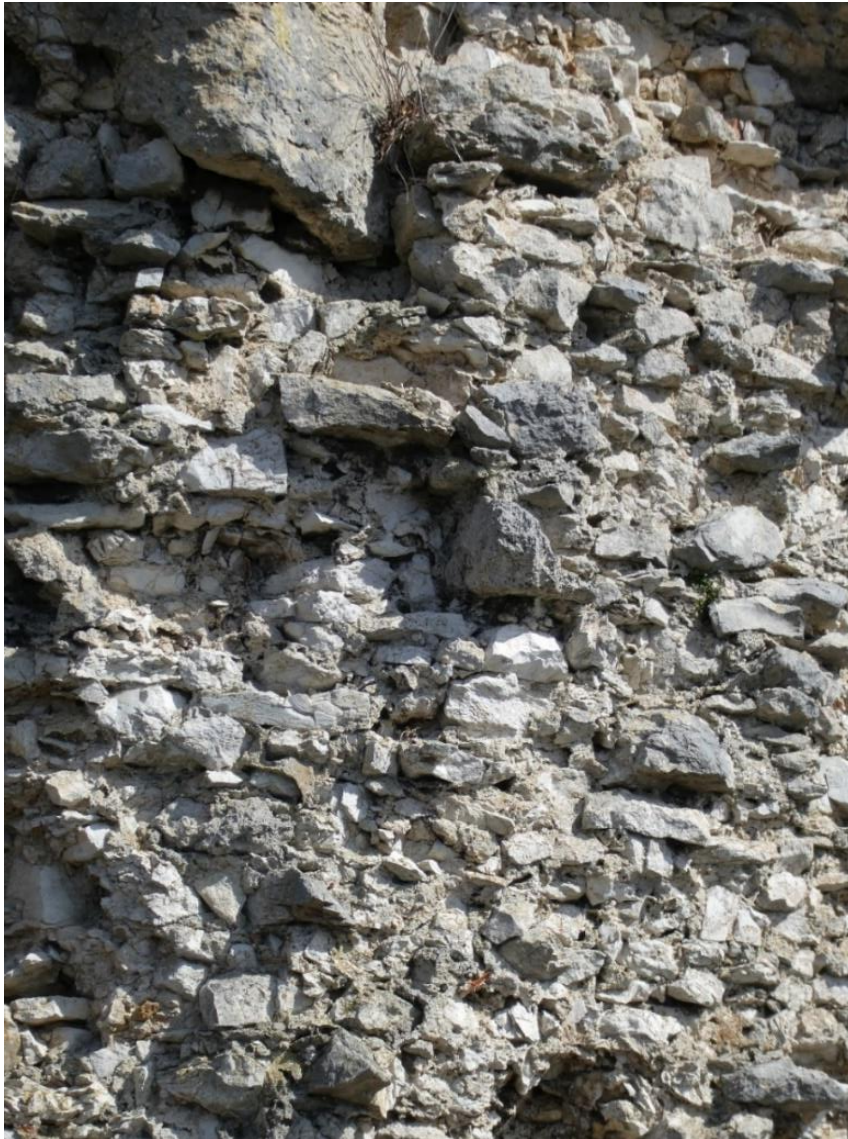
Gefüge der Untermauerung, kaum vom verwitterten Fels zu unterscheiden
