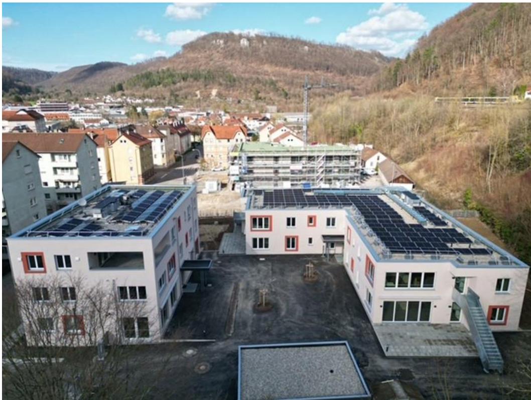
Neubau eines Wohnheims für 24 Menschen mit einem komplexen Hilfebedarf sowie angegliedertem Förder- und Betreuungsbereich, vier Mitarbeiterapartments sowie zehn Pkw-Stellplätzen.
